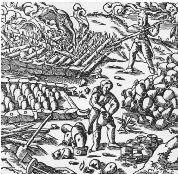
Žganje rude v retortnih ognjiščih iz knjige Agricola G: De re metallica, Berlin 1556
