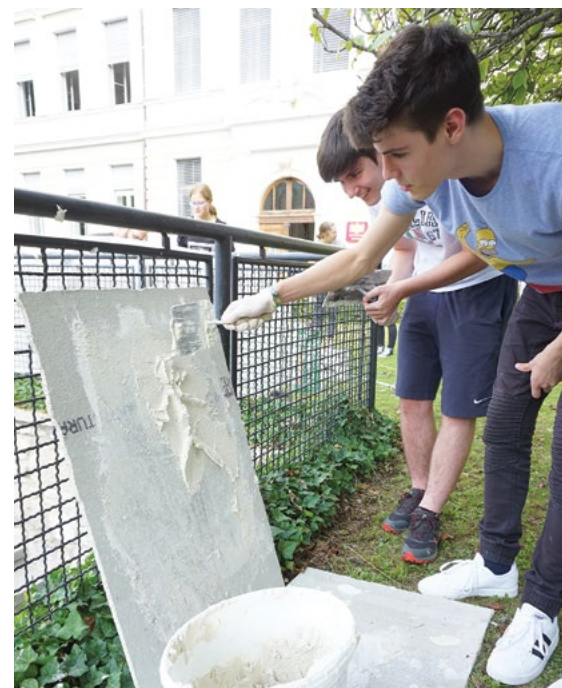
Dijaki so se preizkusili v nanosu apnenega ometa in oblikovanju štukaturnega stavbnega okrasja. /Foto: arhiv Društva Idrija 2020
